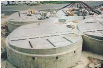
Fondation béton Concrete foundation
