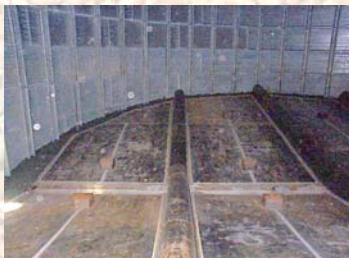
Gaines de ventilation intégrées Aeration ducts
