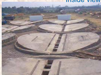
Fondation béton Concrete foundation
