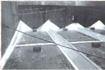
Vue intérieure Inside view
