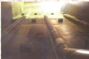
Vue intérieure Inside view
